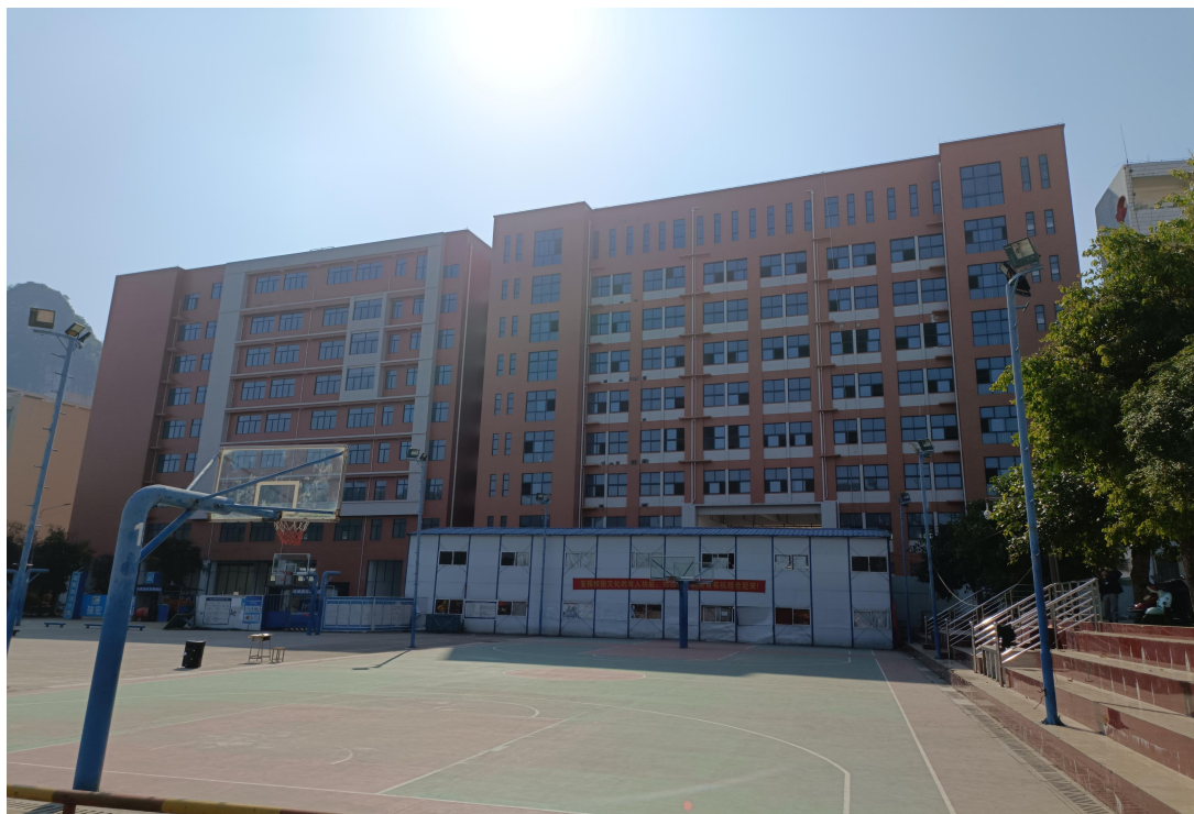
图 4.5-1 新建产教融合综合1号楼、2号楼
